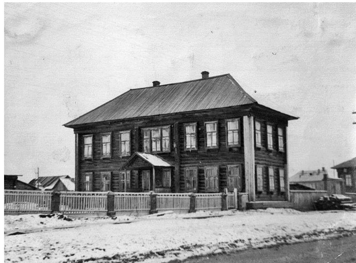
Здание начальной школы в центре с. Шаркан.
